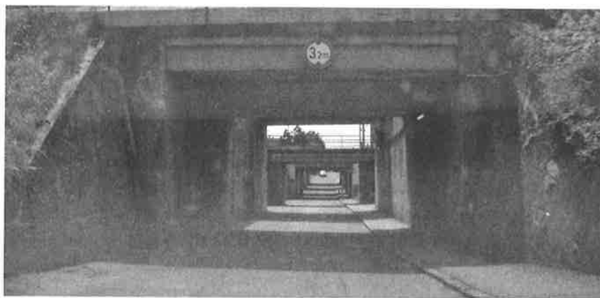
Sieben Eisenbahnbrücken trennen Strasshof und das historische Bartoschviertel
