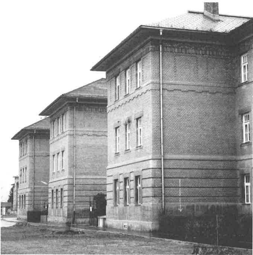
Arbeiter-Wohnhäuser von 1908 direkt an den Geleisen
